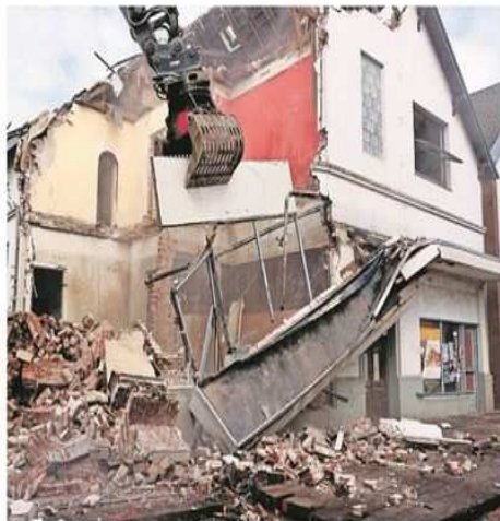
Der Abbruch der von der GNSG aufgekauften Gebäude in der nördlichen Fußgängerzone ist schon weit vorangeschritten. Foto: Blumenkamp
